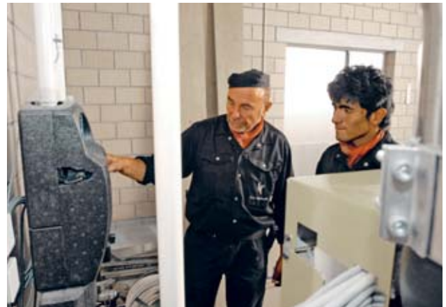
2 Besprechung der Situation vor Ort.
