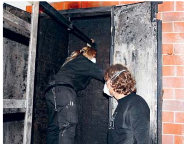
6 Personenüberwachung: Eine Person befindet sich im Feuerungsraum (Rauchkammer), die zweite Person überwacht von aussen.
