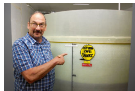
Dank der transparenten Tankwand sieht Bruno Hellmüller auf einen Blick, wie viel Heizöl noch vorrätig ist.
