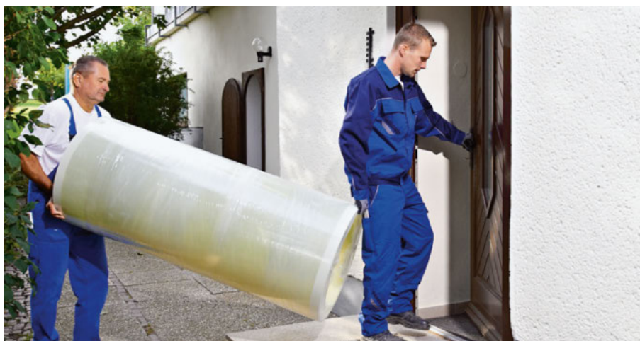
Beim Aufbau eines Haase-Tanks sind keine Abbruch- und Maurerarbeiten notwendig, da die Montage der zusammengerollten Wand erst im Keller erfolgt.
