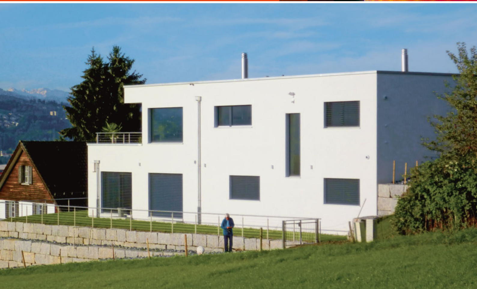
Im Neubau der Familie Capuano in Abtwil SG wird mit Heizöl geheizt.
